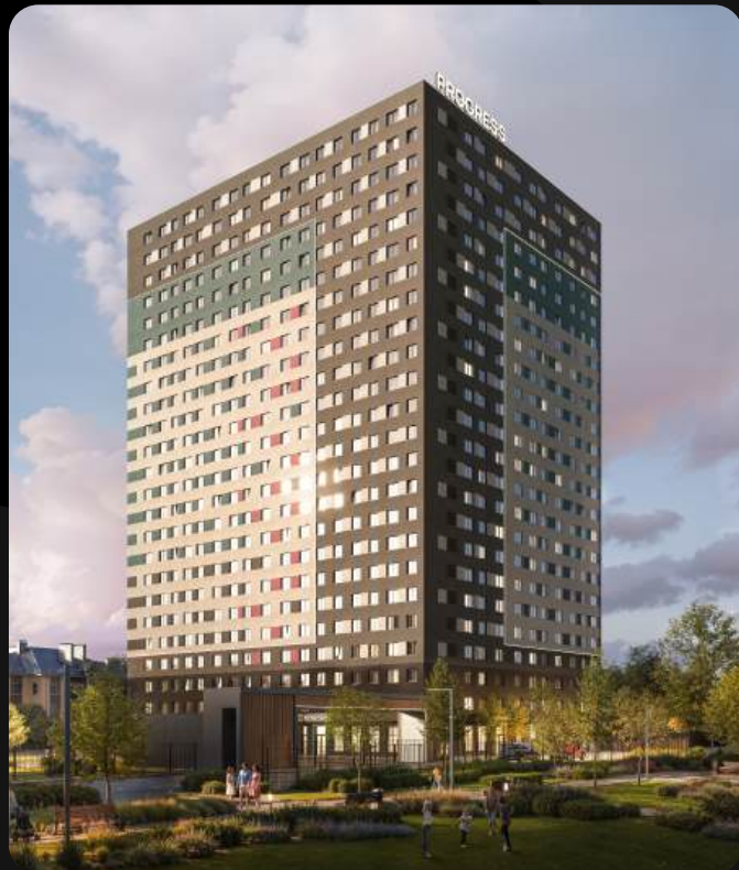
● PROGRESS Приволжский затон
