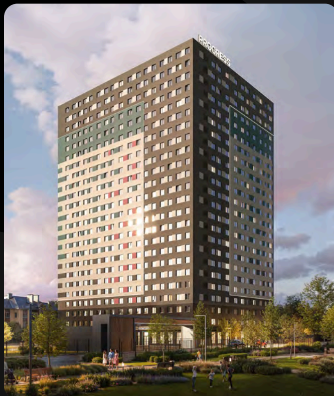
● PROGRESS Приволжский затон
