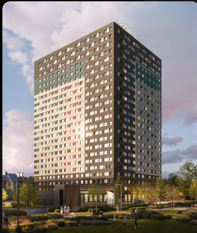
● PROGRESS Приволжский затон
