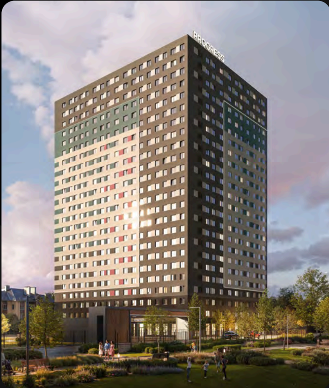
● PROGRESS Приволжский затон
