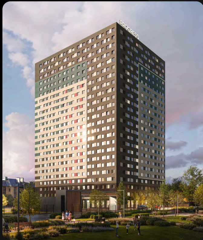
● PROGRESS Приволжский затон
